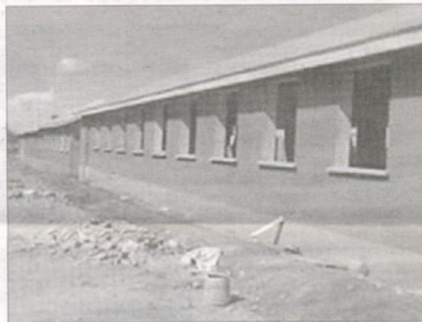
Il cantiere I lavori procedono
